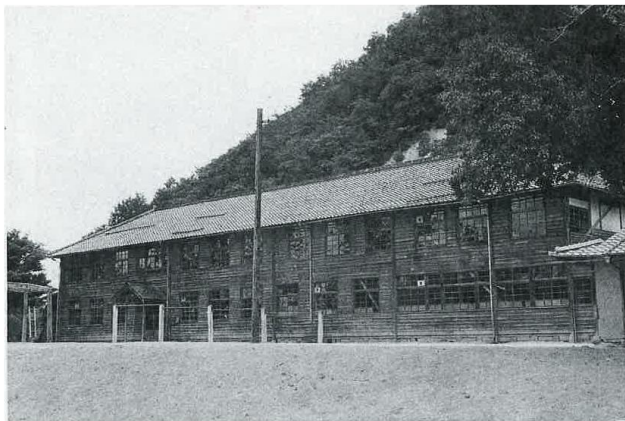
〔昭和22年〕 校舎修繕終わる（各教室にスジカイが見える）
